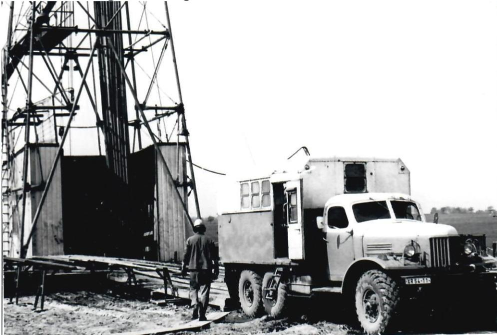
Bild 2: Einbau Bohrgestänge mit Umlenkrolle (Unterflasche = Jargon Uhu) und Förderöse an mobiler Bohranlage SKB 650 Brigade Langguth Revier Delitzsch 1985 rechts hinten 4x4 UAS 469B, Mitte hinten Arbeits- und Umkleidehänger am Bohrpunkt
